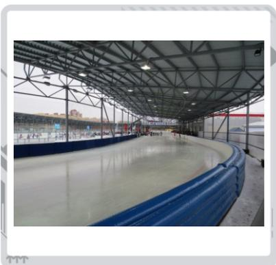
Особенностью проекта является принятая для уменьшения эксплуатационных нагрузок на инженерные сети города концепция сезонной трансформации. Поскольку комплекс является открытым, при температуре наружного воздуха +10°C и ниже комплекс работает на зимние виды спорта, при температуре +11°C и выше — на летние. Проект разработан по заказу Комитета по физической культуре и спорту правительства г. Санкт-Петербурга.
