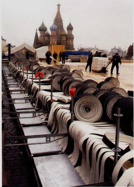
Слой льда толщиной 50 мм намораживается непосредственно на поверхность трубных матов. Когда мы начинали заливку катка, температура воздуха была 5°С. Это, конечно, очень тяжелый режим. Сложность была и в том, что в ледовое поле необходимо было «вморозить» логотипы ТД «ГУМ» и Bosco di Ciliegi. Каток заливали слой за слоем, чередуя
