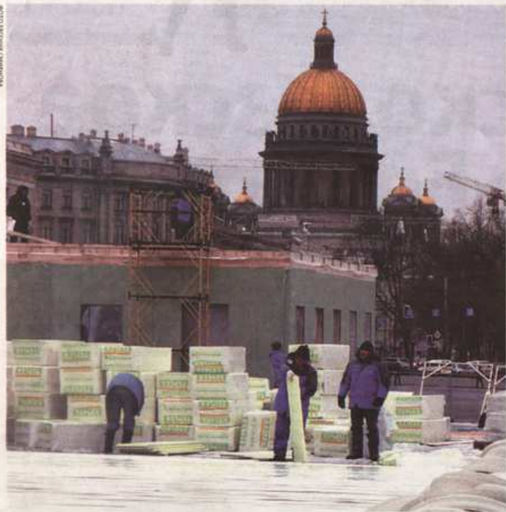
Сначала площадку на Дворцовой утеплили и покрыли специальными матами...
